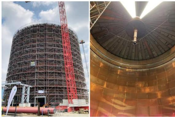
**Abb. 12:** Bau des 2-Zonen-Speichers am Standort Reuter West in Berlin Spandau mit Blick in den noch leeren Speicher<sup>7</sup>
